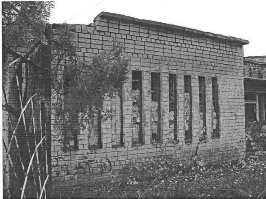
Від надмірної вологи, вітру і морозу силікатна цегла розклаталась на глибину до 90мм.
