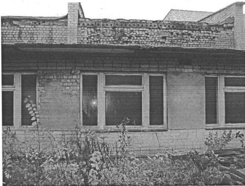
Від надмірної вологи спостерігається вимивання та висипання цегли
