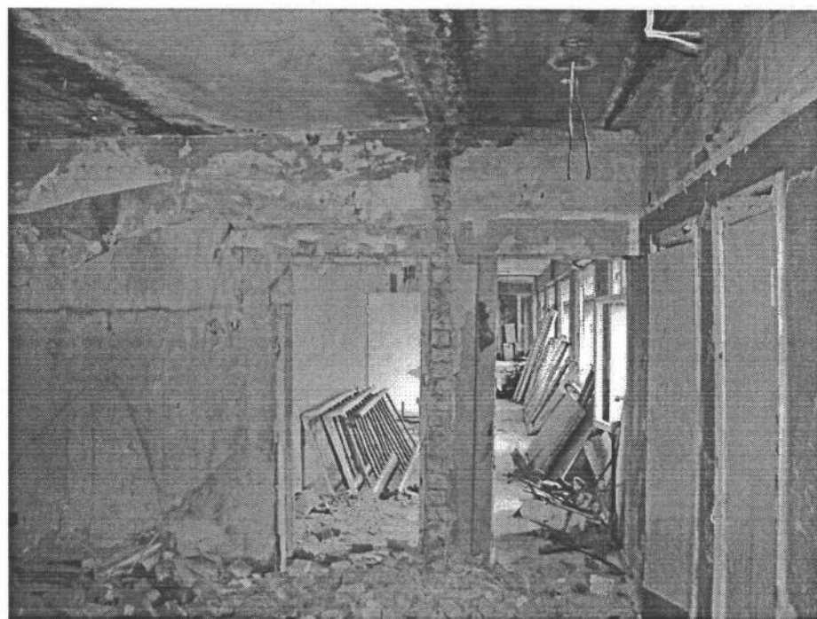
Внутрішній стан будівлі
